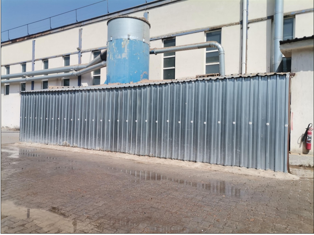
Foto-1: Bakımı ve Temizliği Sağlanmış Kırpıntı Mukavva Filtresi
